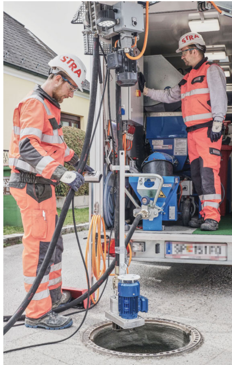
1+2 Wasserhochdruckdüse / 3 Schacht vor Reinigung / 4 Schacht nach Reinigung / 5 Schacht nach Beschichtung
