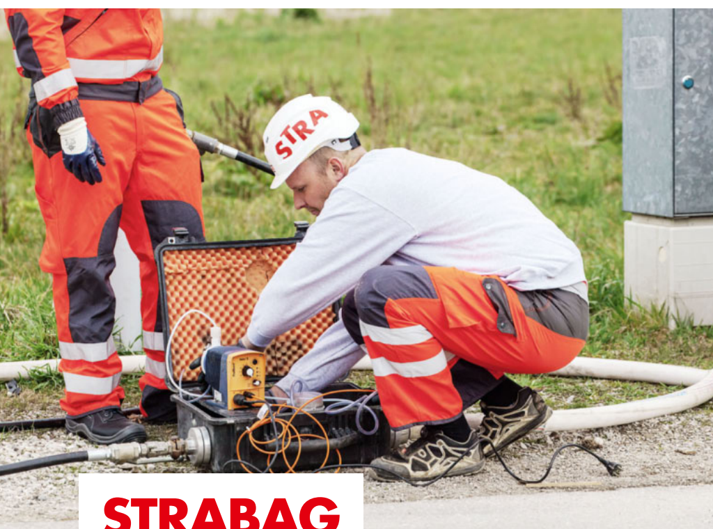
Aufbau der Desinfektionspumpe
