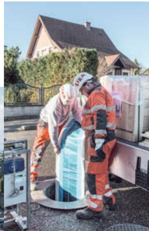
1 Schlauchliner-Fuhrpark / 2 Einbringen eines GFK-Inliners / 3 Sanierter Ei-Profil-Kanal / 4 Ständige Druck- und Temperaturkontrolle / 5 Einbringen der UV-Lichterkette
