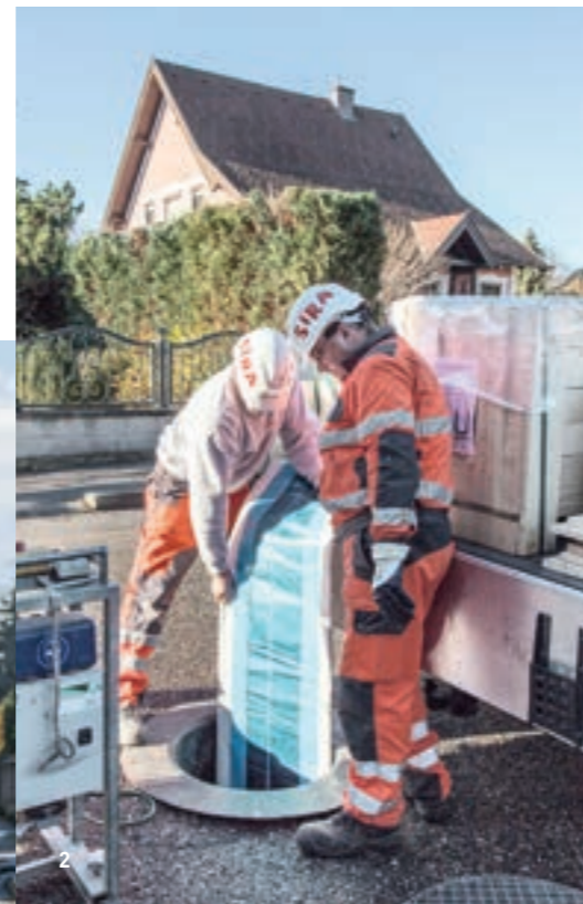
1 Schlauchliner-Fuhrpark / 2 Einbringen eines GFK-Inliners / 3 Sanierter Ei-Profil-Kanal / 4 Ständige Druck- und Temperaturkontrolle / 5 Einbringen der UV-Lichterkeine
