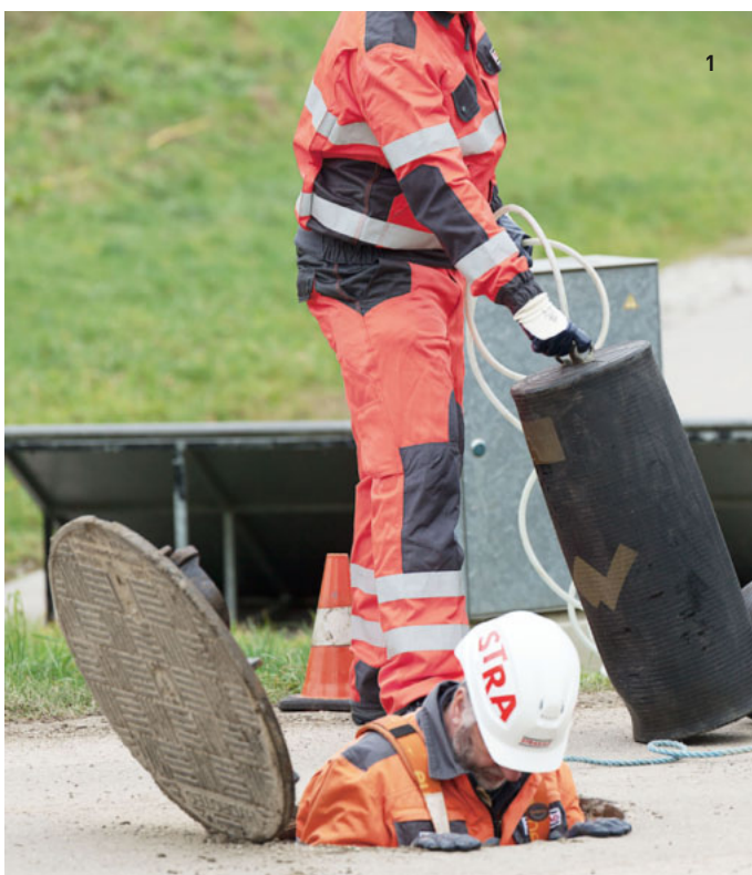
1 Einbau der Dichtkissen / 2 Dichtkissen in Rohr / 3 Dichtheitsprüfung einer Wasserleitung
