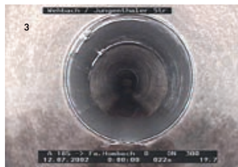
1 Spezialpacker mit Edelstahlmanschette/ 2 Patentierter Verschluss / 3 Eingebaute Manschette
