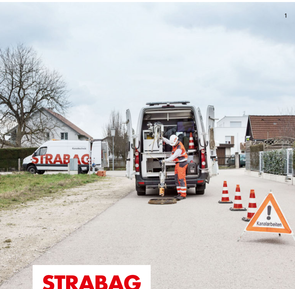
1 Einsetzen der Kamera im Kanal/ 2 PEGASUS HD mit Lift
